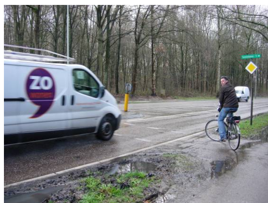
Foto 5.6 korte tussenruimte fietspad en rijbaan
