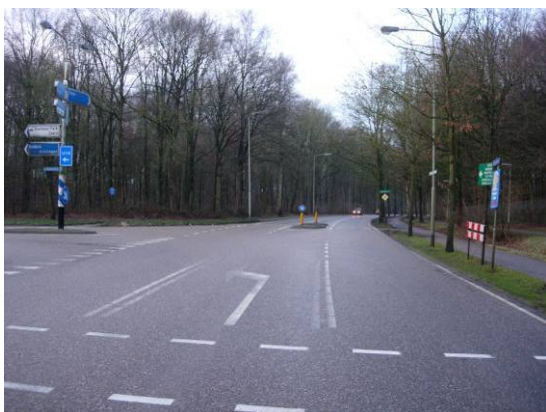
Foto 5.9 Beperkt zicht op tegemoetkomend verkeer
